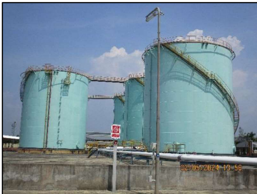
ภาพถ่ายที่ 2.2-25 ระบบฉีดน้ำดับเพลิงและระบบสเปรย์น้ำหล่อเย็น บริเวณถังเก็บน้ำมัน
