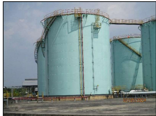
ภาพถ่ายที่ 2.2-25 ระบบฉีดน้ำดับเพลิงและระบบสเปรย์น้ำหล่อเย็น บริเวณถังเก็บน้ำมัน
